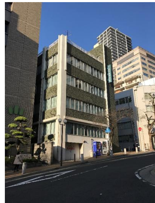
南東より 敷地は傾斜しており、約1.4mの高低差がある
